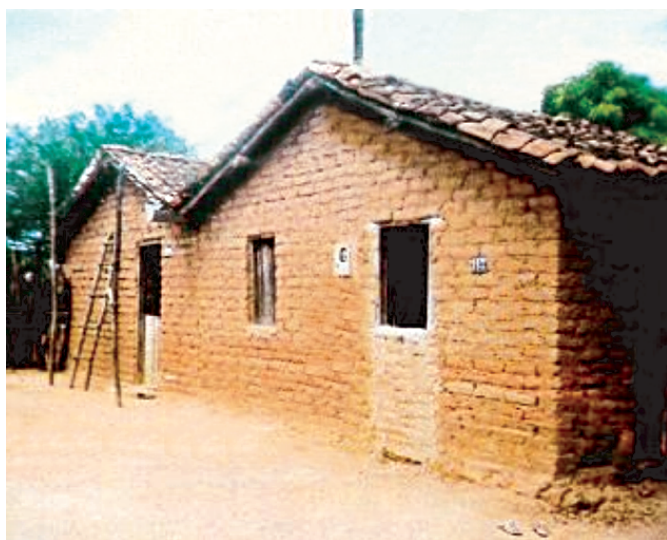
Figura 1. Casa antes da restauração
