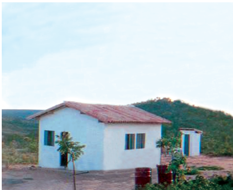
Figura 4. Casa depois da reconstrução
