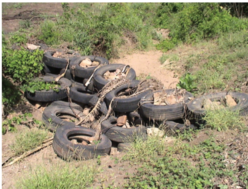
Figura 3 – Bapucosa 8, após chuvas de janeiro de 2005, apresentando um pneu da camada final deslocado e segurado pela vara de ferro
